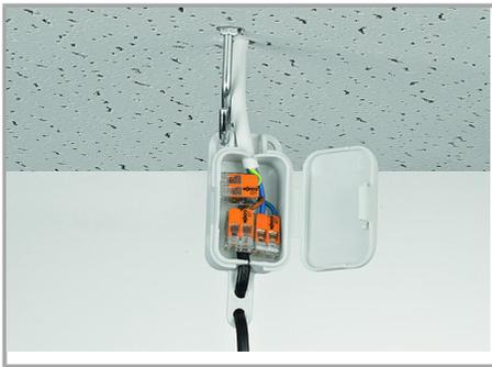
Anschluss von Pendelleuchten in abgehängten Decken
