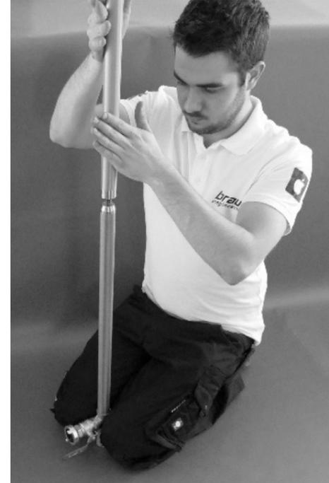
Sollten Sie Widerstand beim Einschrauben bemerken, verwenden Sie keinesfalls den Gabelschlüssel, um die Verlängerung einzuschrauben!
